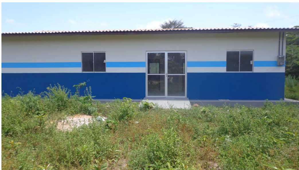
Foto 72 – Estágio da obra de construção da UBS de Bairro Alto – 22.08.2016. 2016
