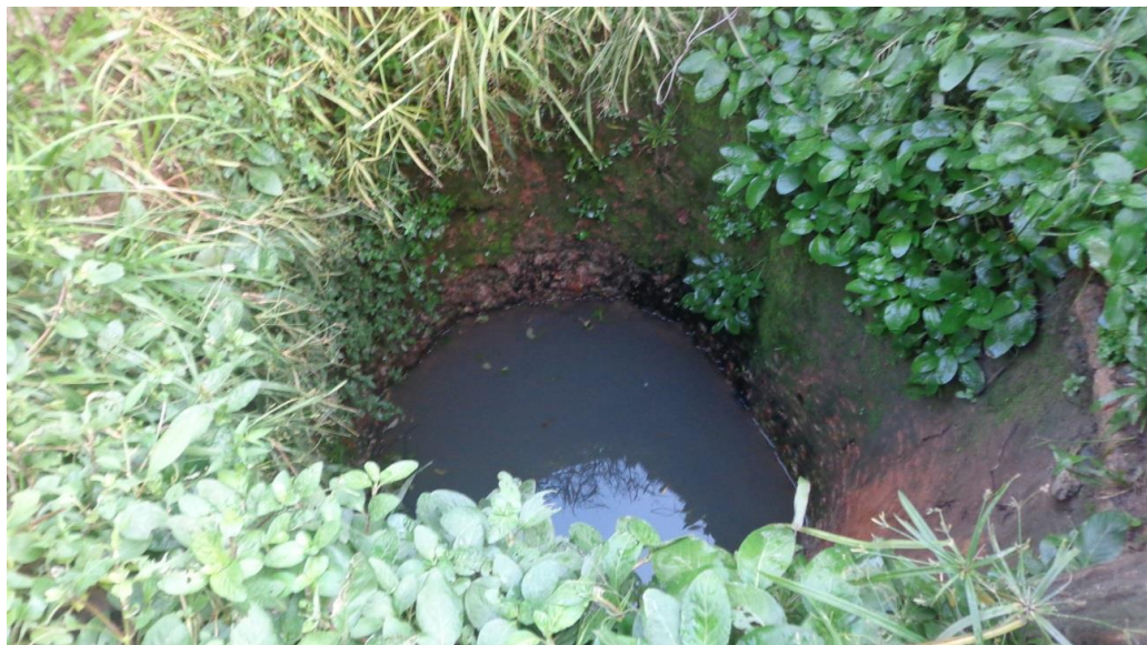
Foto 10 – Vista interna de poço em Salvar. 2015
