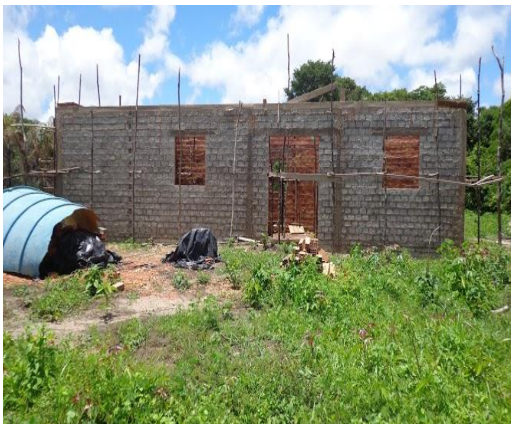
Foto 71 – Estágio da obra de construção da UBS de Bairro Alto – 08.03.2015. 2015
